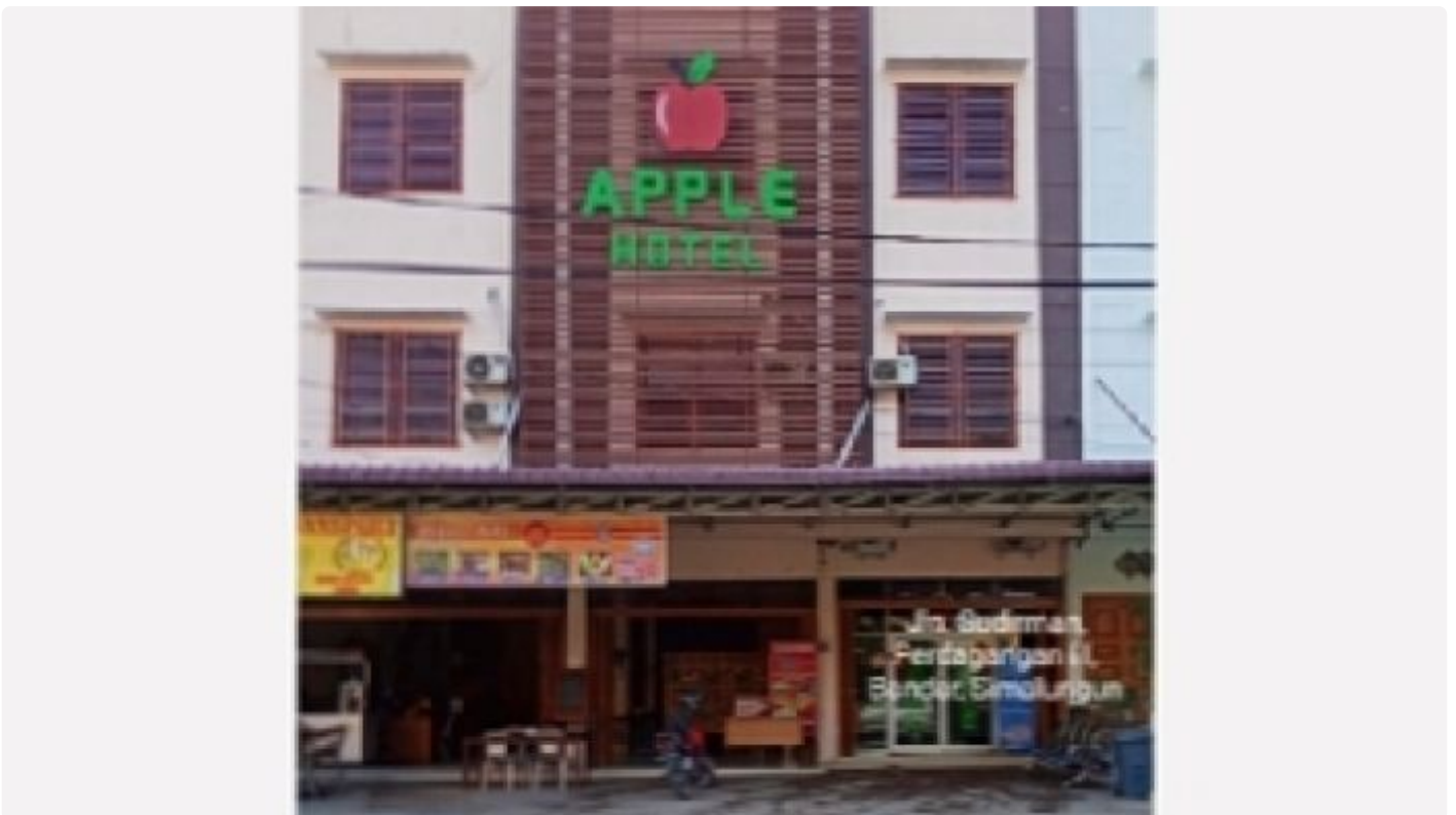
Keterangan Photo : Bangunan Hotel Apple Perdagangan
