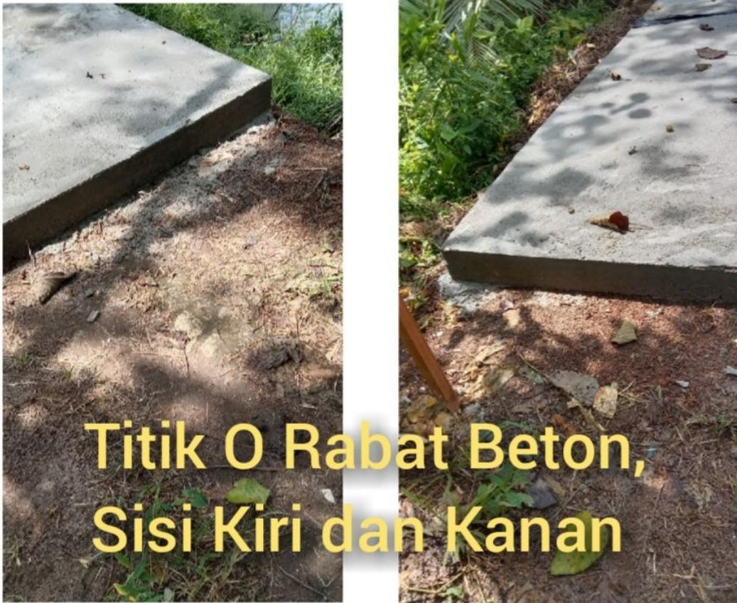
Amatan awak media ini di lokasi, terkait proses pengerjaan rabat beton yakni profil jalan telah dilakukan onderlaag batu padas, gelombang tanah pada jalur jalan diratakan secara manual dan campuran material menggunakan Mesin Molen Pengaduk Semen Cor Beton, sedangkan proses pengerjaan mencapai 30 % saat awak media ini datang ke lokasi
